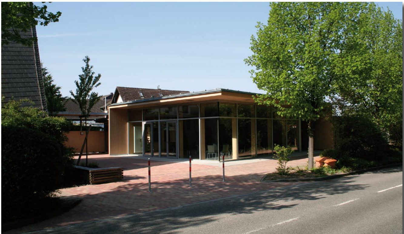
Mit dem Bau des Gemeindehauses hinter dem Gotteshaus in der Sinzheimer Hauptstraße ging 2009 ein lang gehegter Wunsch der Evangelischen Matthäusgemeinde in Erfüllung.
