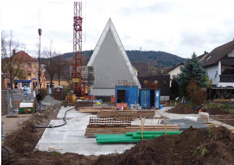
11.11.2008: Die Bodenplatte konnte noch vor den Wintermonaten betoniert werden.
