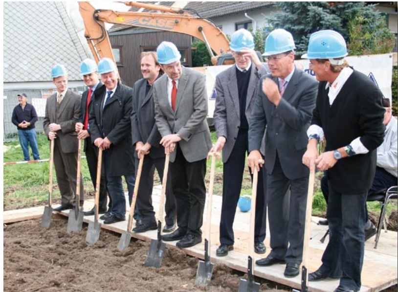
9.10.2008: Was lange währt ... Erster Spatenstich zum Neubau des Gemeindehaus der Evangelischen Matthäusgemeinde. Pfarrer Jürgen Knöbl, Bürgermeister Hans Metzner (v. r.) und weitere „Helfer“ freuen sich über den Beginn der Bauarbeiten.
