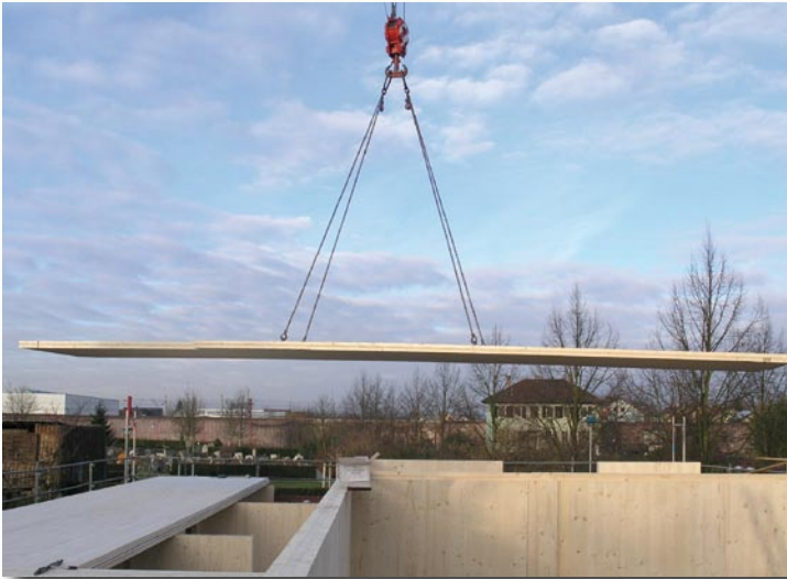
27.11.2008: Die in Holzbauweise errichteten Wände werden in kurzer Zeit montiert.
